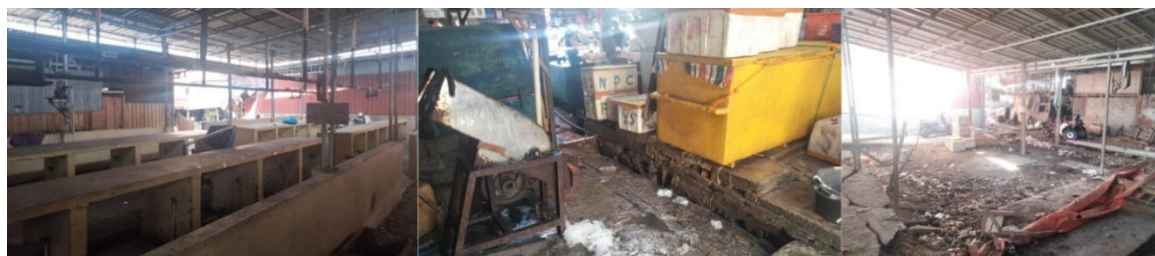
Gambar 2. Kondisi Ruang Pasar Masomba
