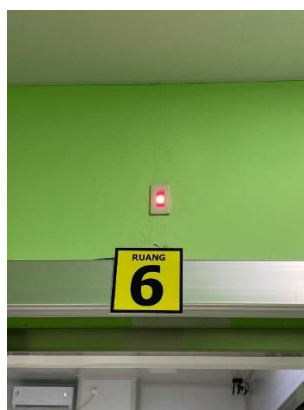
Gambar 5. Lampu merah disetiap ruangan di Instalasi Radiologi (RSUD dr.R Soetijono Blora.)
